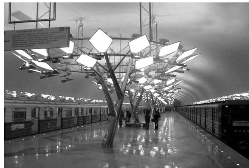
Рис. 4. Светодиодное освещение станции метро «Тропарево»
