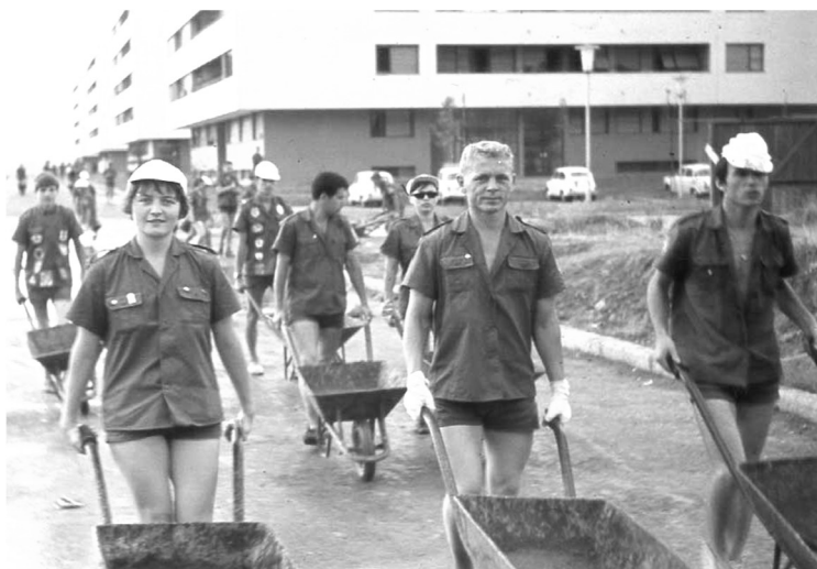
1968 г. Югославия. Строительство автомагистрали Белград – Загреб
